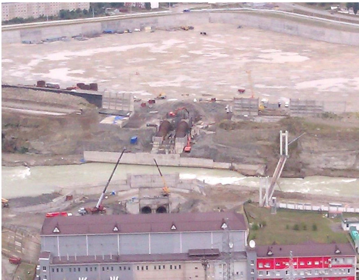
Рисунок 3.30. Строительство сооружений нижнего бассейна
