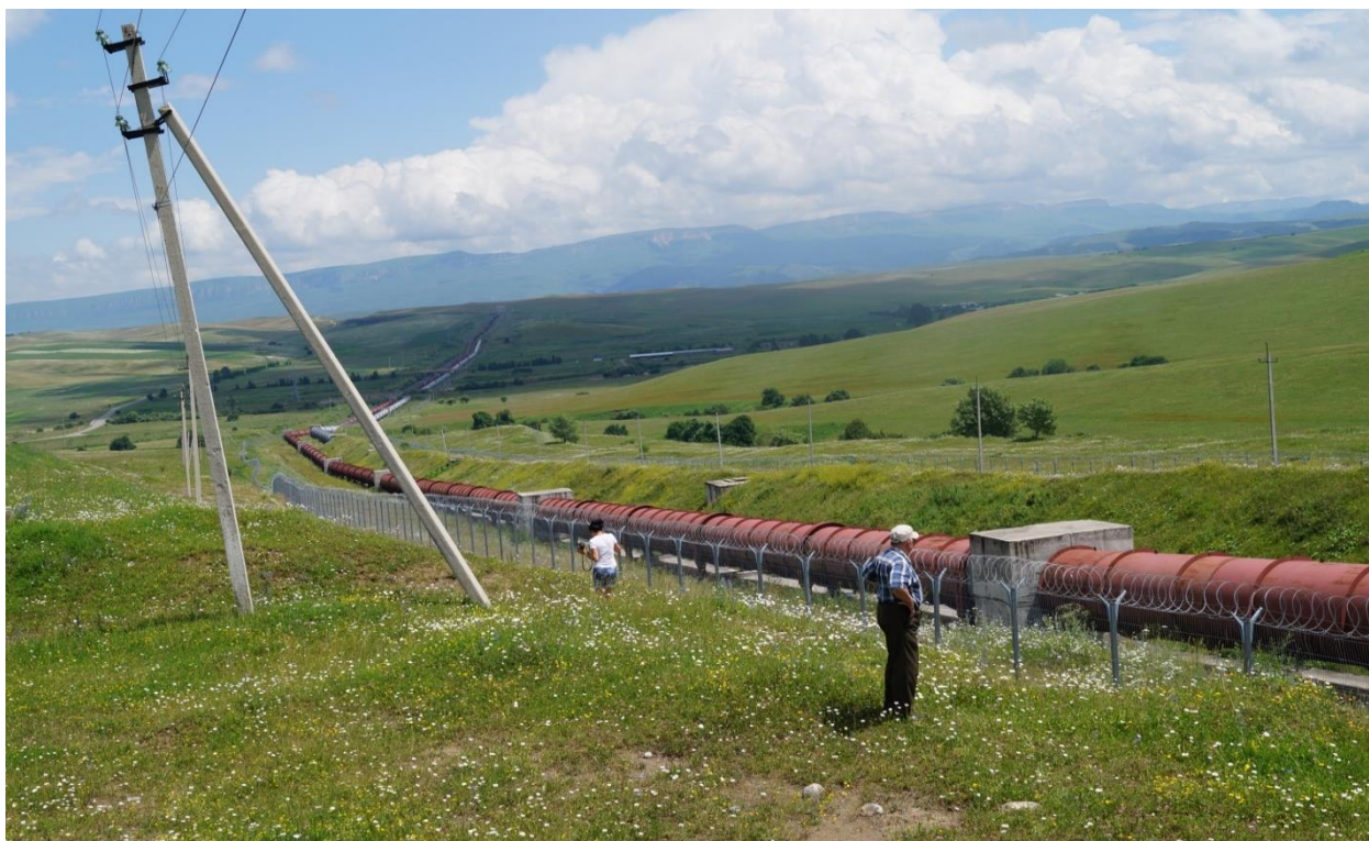
Рисунок 3.15. Дюкер через р. Кардоник
