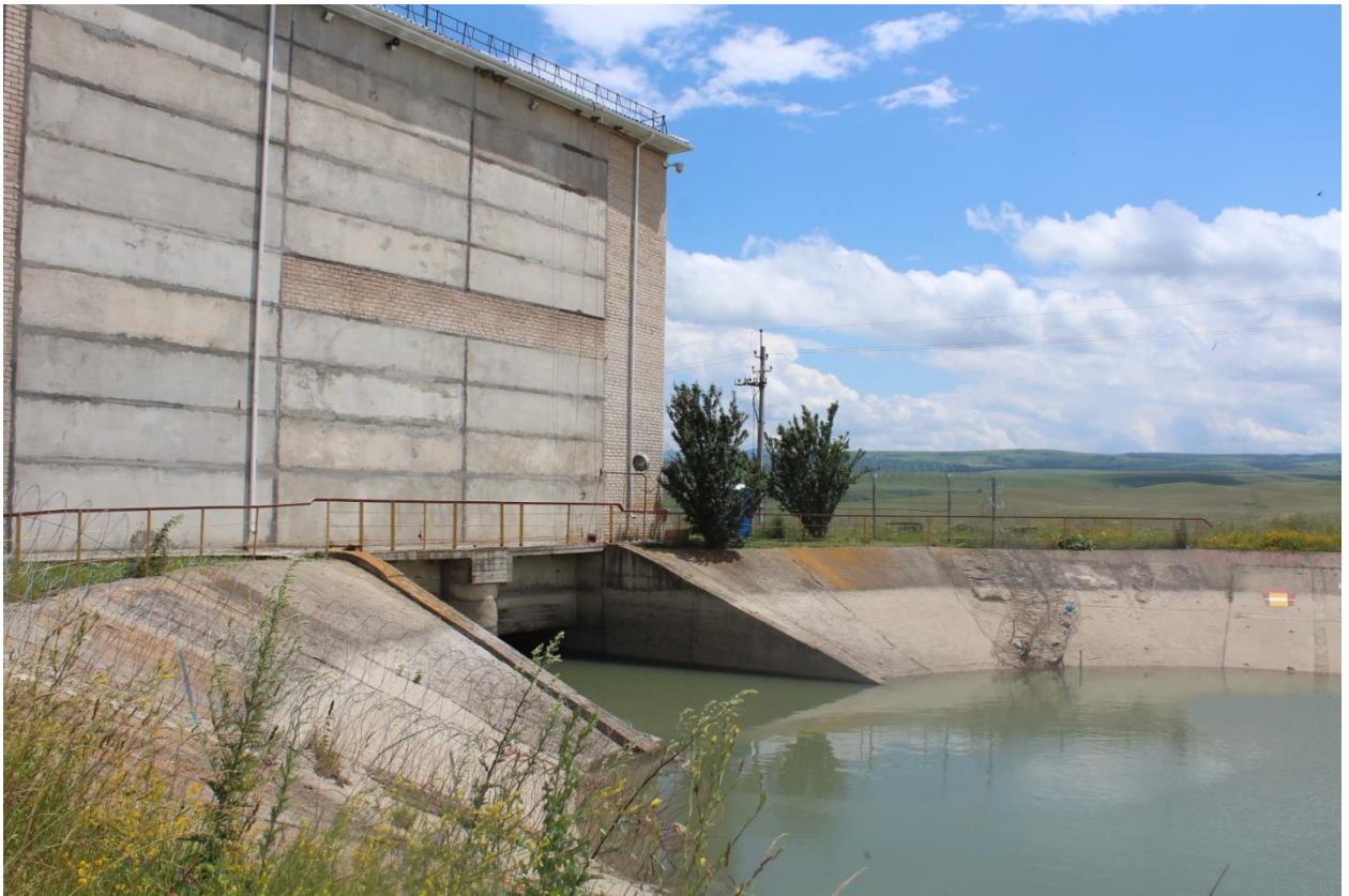
Рисунок 3.18. Верхнее строение шлюза-регулятора на канале Кубыш – БСР.
