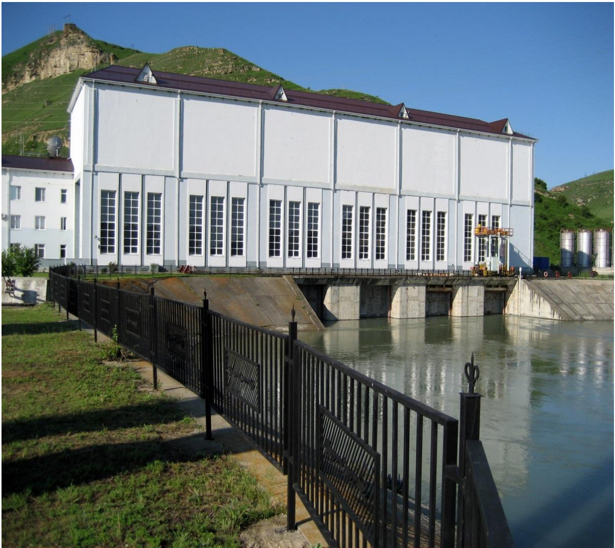
Рисунок 3.24. Здание ГЭС-ГАЭС с административно-бытовым корпусом.
