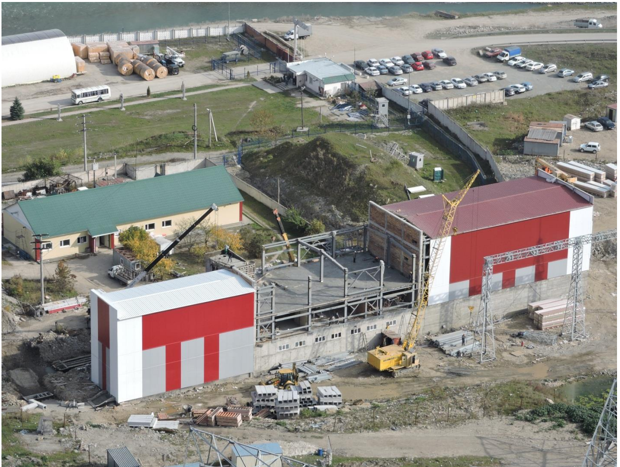
Рисунок 3.25. Строительство здания КРУЭ 110-330 кВ
