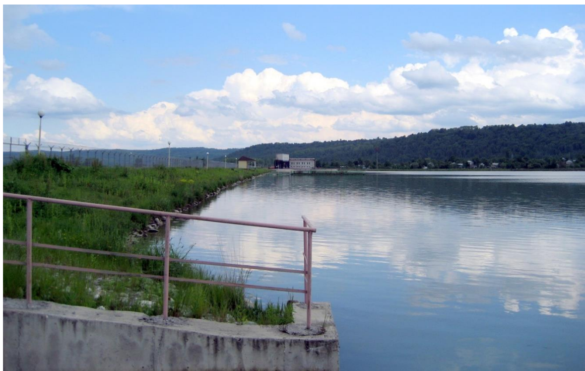
Рисунок 3.2. Вид на водозаборный гидроузел на Большом Зеленчуке.
