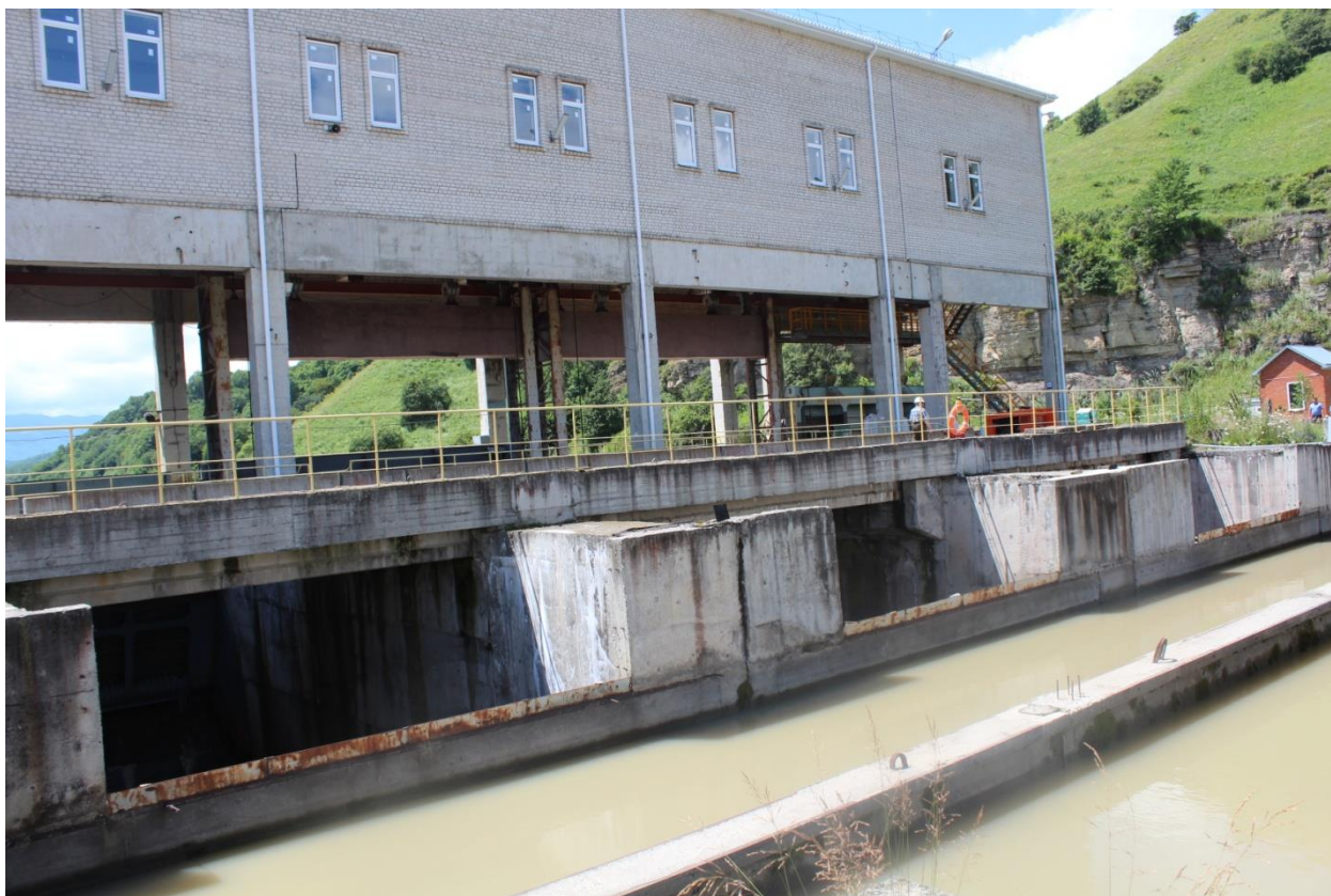
Рисунок 3.13. Верхнее строение водосброса
