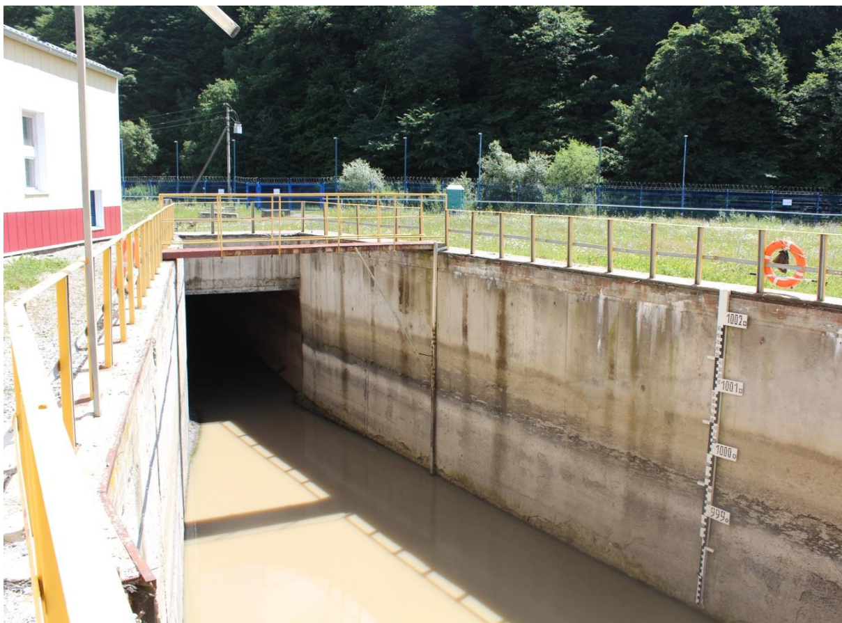
Рисунок 3.10. Входной портал туннеля Маруха – Аксаут
