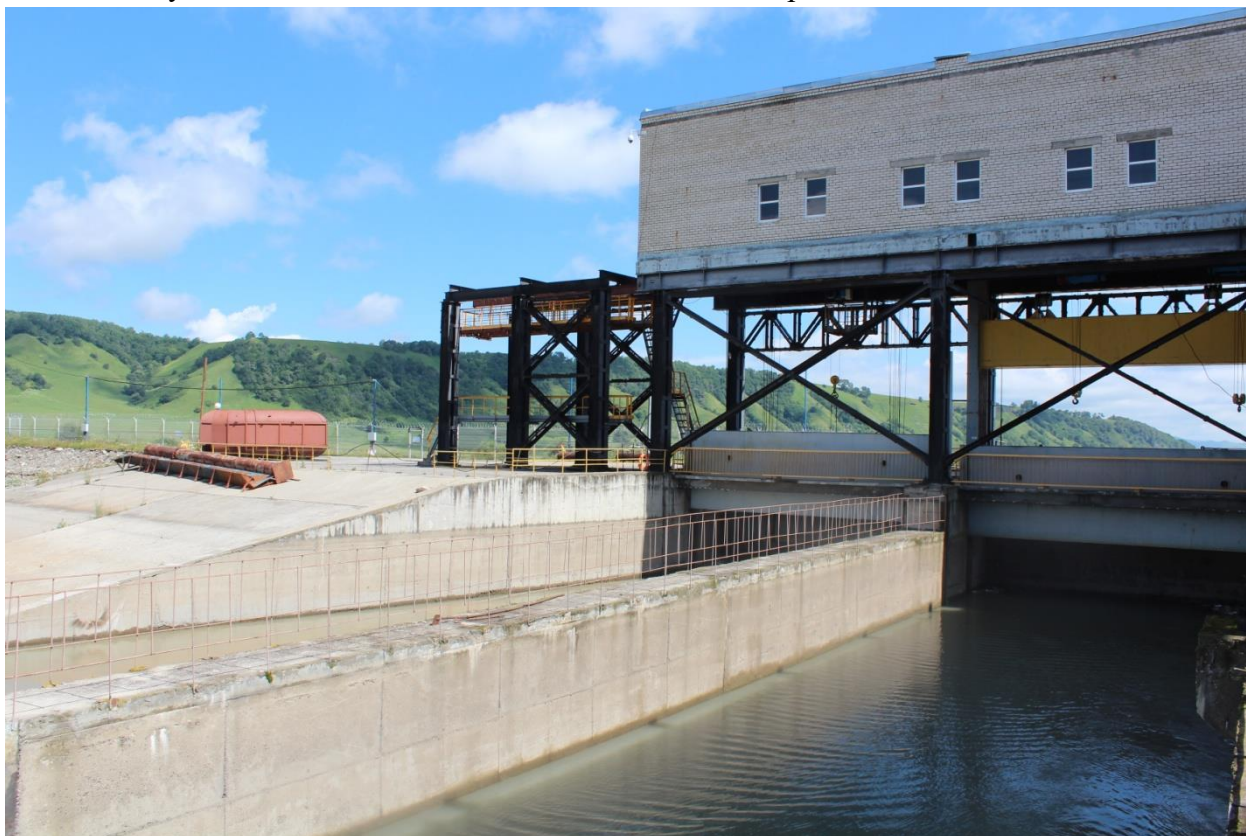
Рисунок 3.5. Верхнее строение водосбросного сооружения
