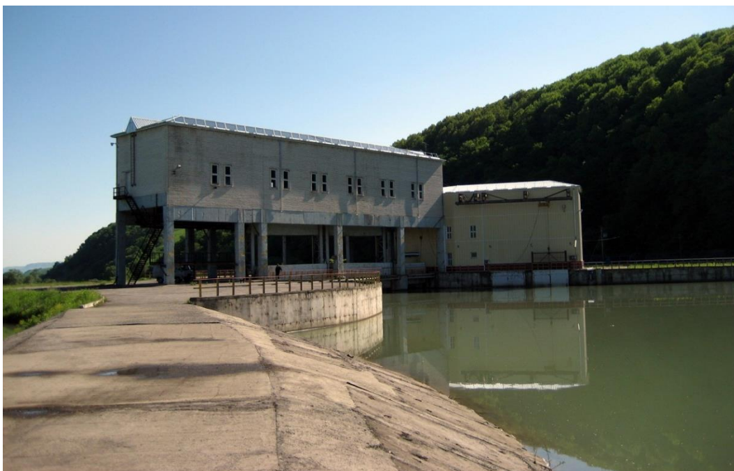
Рисунок 3.8. Водозаборный гидроузел на р. Маруха.
