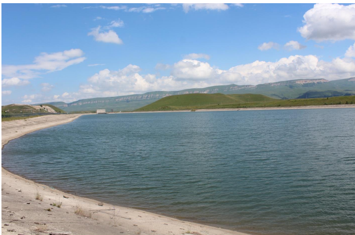
Рисунок 3.20. Бассейн суточного регулирования (верхний бассейн ГЭС-ГАЭС)
