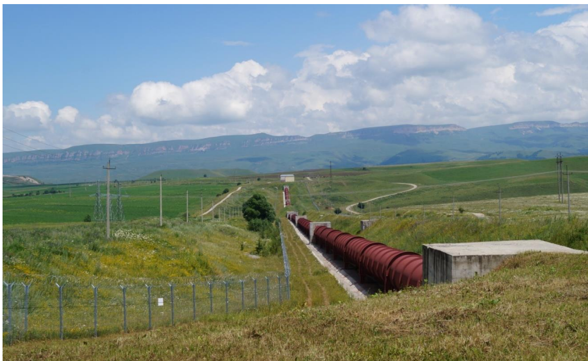
Рисунок 3.16. Дюкер через балку Кубыш.
