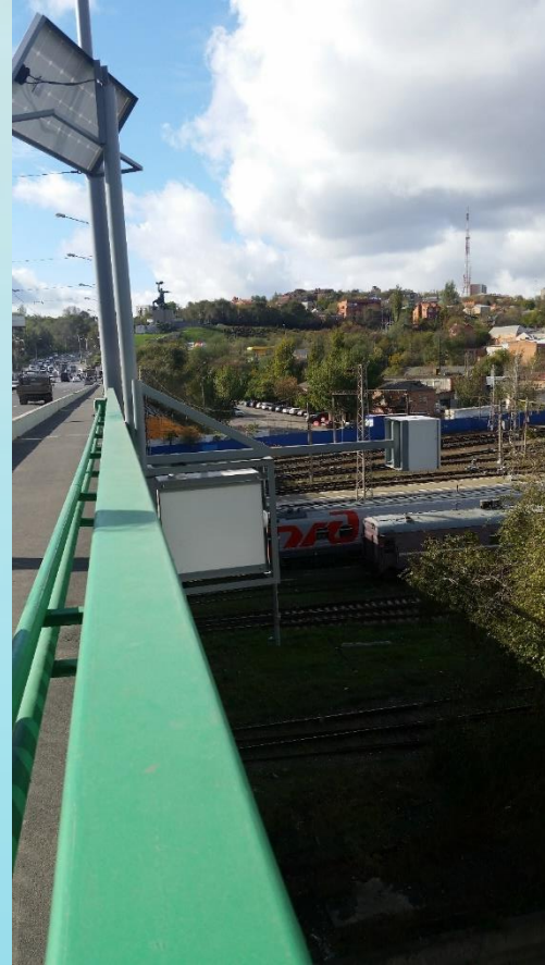
АГК-239, мост пр. Стачки
