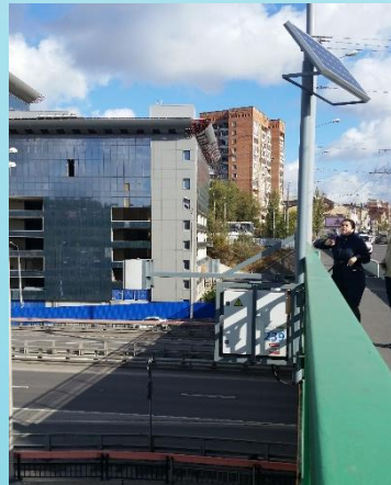
АГК-239, мост пр. Стачки
