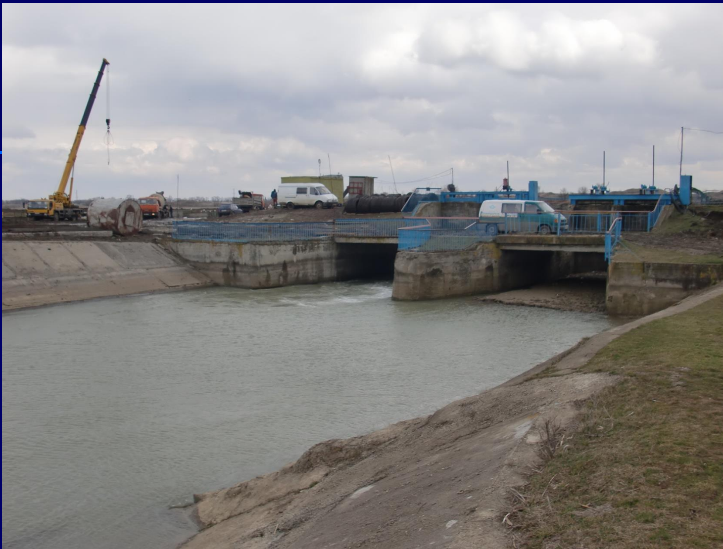
Перепад № 3 на р. Егорлык в месте предполагаемой малой ГЭС
