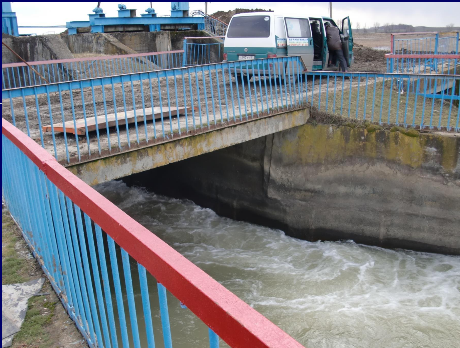
Перепад № 2 на р. Егорлык в месте предполагаемой малой ГЭС
